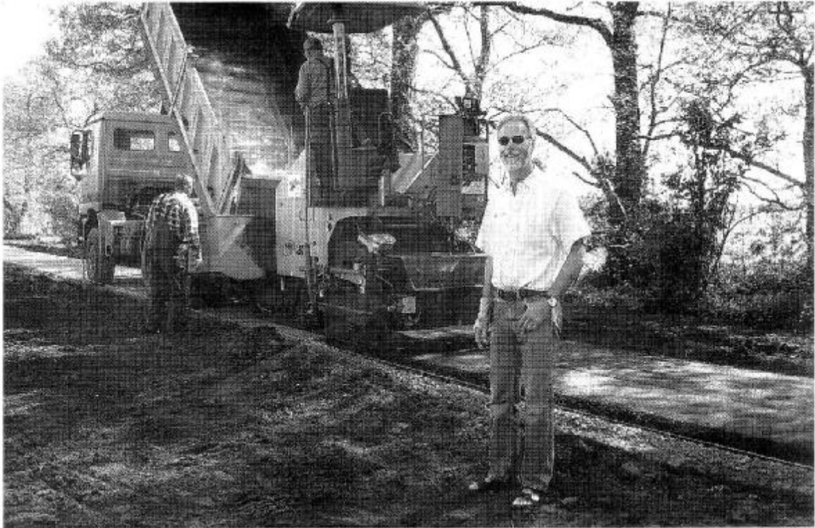
Manfred Kallendorf freut sich über die Bauarbeiten am neuen Radweg nach Eckstever. Voraussichtlich Mitte Mai soll der Radweg fertig sein. FOTO: HEINZ KAHRS
