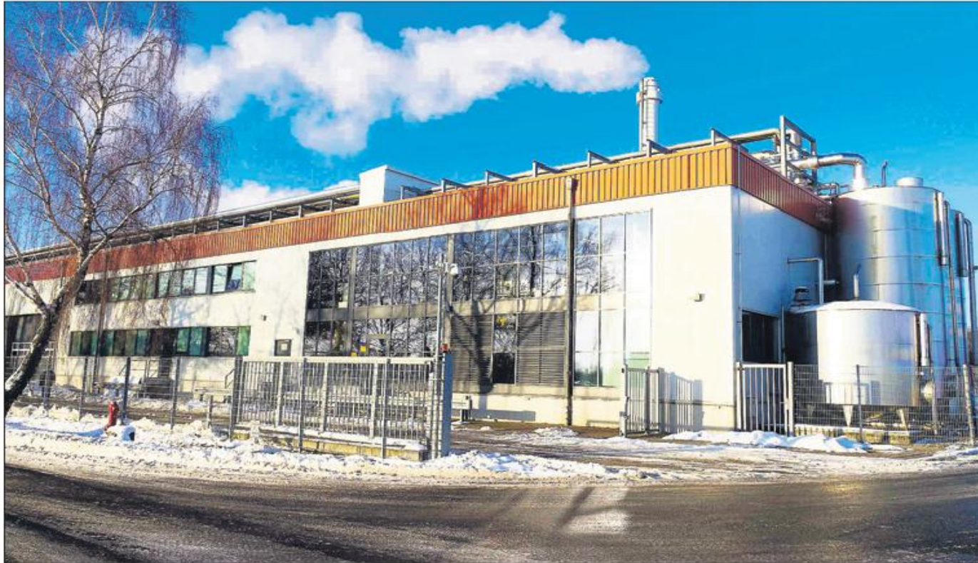
Tonnenweise Dampf benötigt der Ottersberger Fertiggerichte-Hersteller Buss im Produktionsprozess. Seinen immensen Wärmebedarf würde das Großunternehmen künftig am liebsten über ein benachbartes Biomasseheizkraftwerk decken – die Gespräche mit interessierten Investoren laufen. Im ersten Halbjahr 2011 soll die Entscheidung fallen. Foto: Woelki
