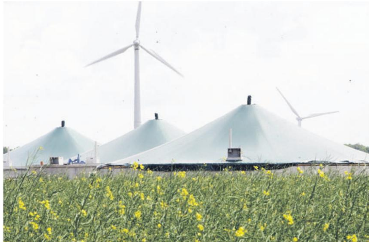
Die Benas-Biogasanlage bei Ottersberg sorgt wieder einmal für Diskussionen. Die SWB will hier in Kooperation mit dem Betreiber eine Gasveredelungsanlage einrichten. Bürger befürchten höhere Immissionen durch noch mehr Verkehr. FOTO: HANS-HENNING HASSELBERG
