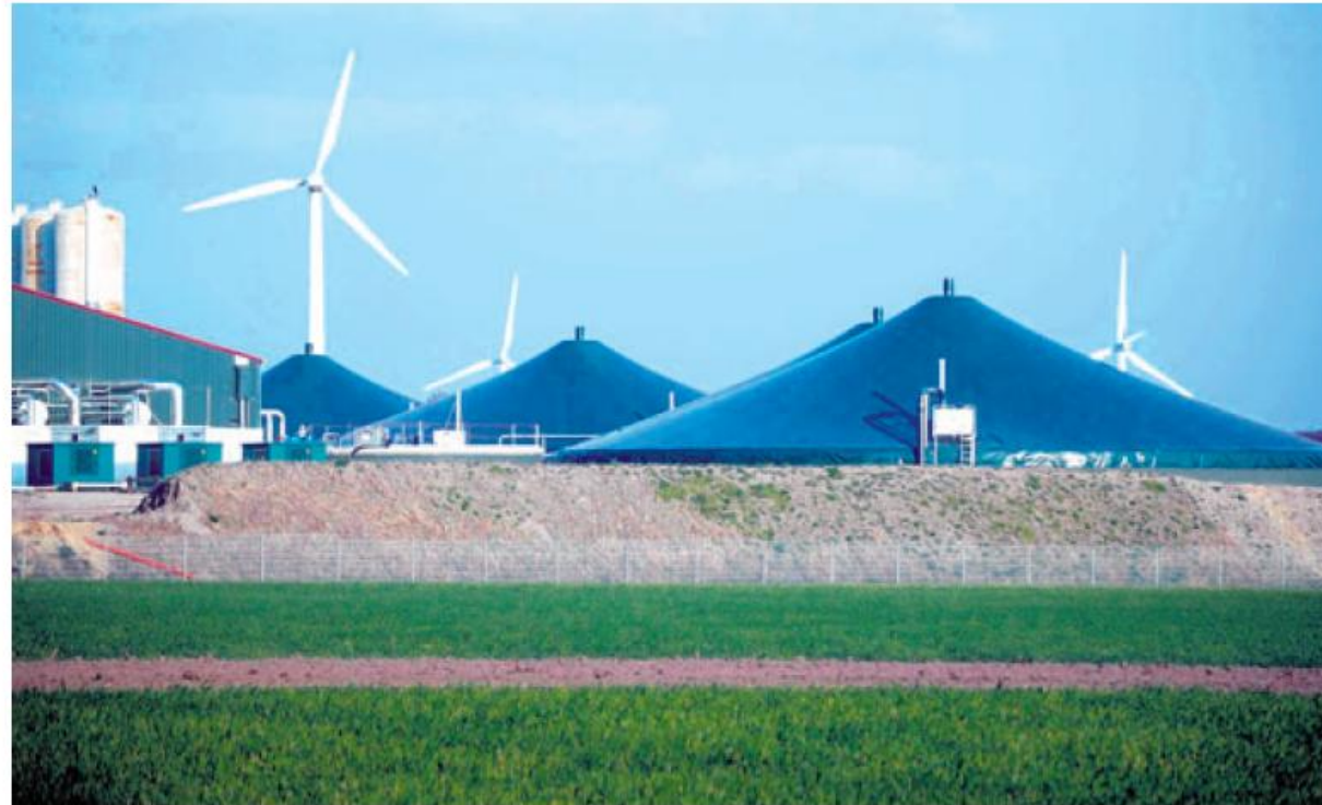
Auf dem Gelände der Biogasanlage in Ottersberg möchte die Bremer Firma SWB gern eine weitere Gasbereitungsanlage errichten. FOTO: DAMMANN
